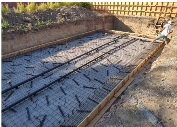
Slika 2. Postavljanje cevnog razvoda i slivnika
